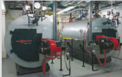
Üç geçişli kızgın su kazanı Vitomax HW ile kurulmuş bir kazan dairesi
