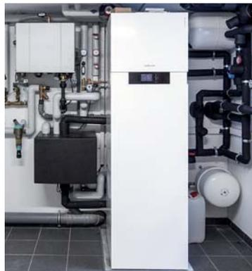
Kompaktwärmepumpe Vitocal 343-G mit Solarfunktion zur Trinkwassererwärmung
