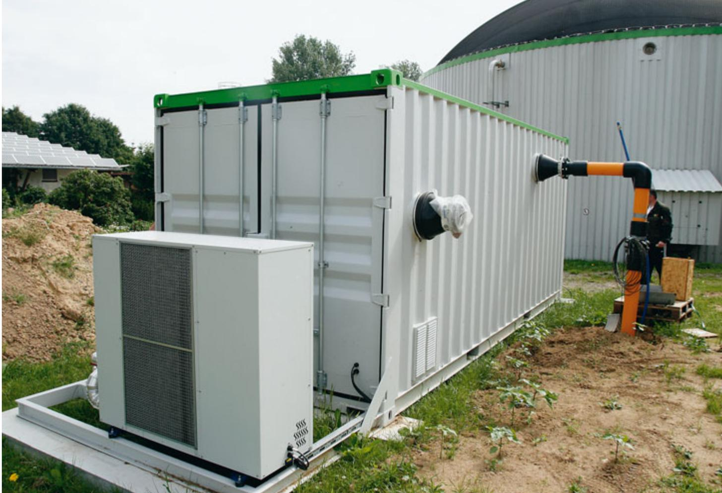
Die Verdichterstation, in der das Biogas nach der Erzeugung aufbereitet wird. Von hier aus gelangt es über eine Mikrogasleitung zu dem Satelliten-BHKW in der Ortsmitte.
